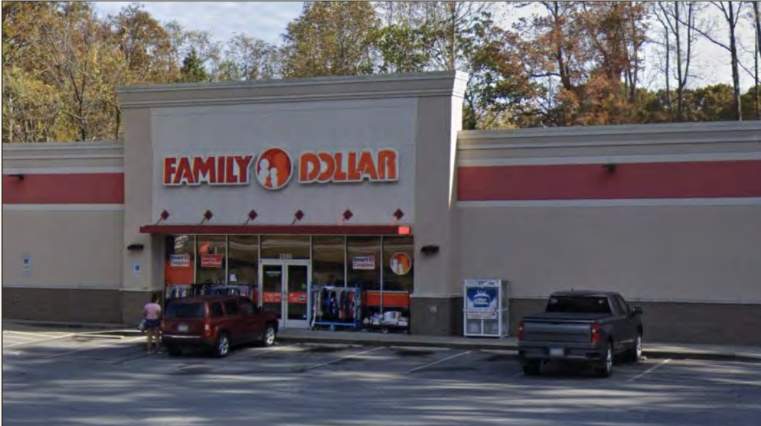
ACTUAL PROPERTY | EAST FLAT ROCK STOREFRONT
